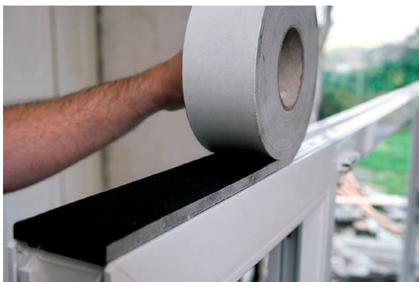
Obr. 4: Páska illmod Trio řeší třívrstvé utěsnění spáry jedním produktem podle pravidla „uvnitř těsněji než venku“. Je vhodná zejména do nových otvorů s pravidelnou spárou, dobře se uplatní např. u dřevostaveb
